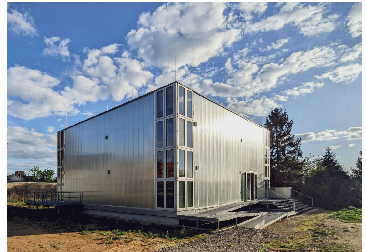
Das Cubity auf dem Poolplatz in Merzenich
